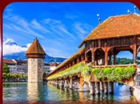
สะพานไม้อาเปลา ลูเซิร์น
