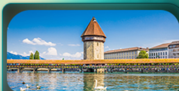
สะพานไมซ์าเปค
