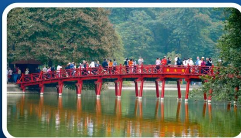
สะพานแสงอาทิตย์
