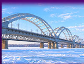
สะพานรถไฟพินโจว
