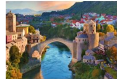
สะพานเก่า Mostar
