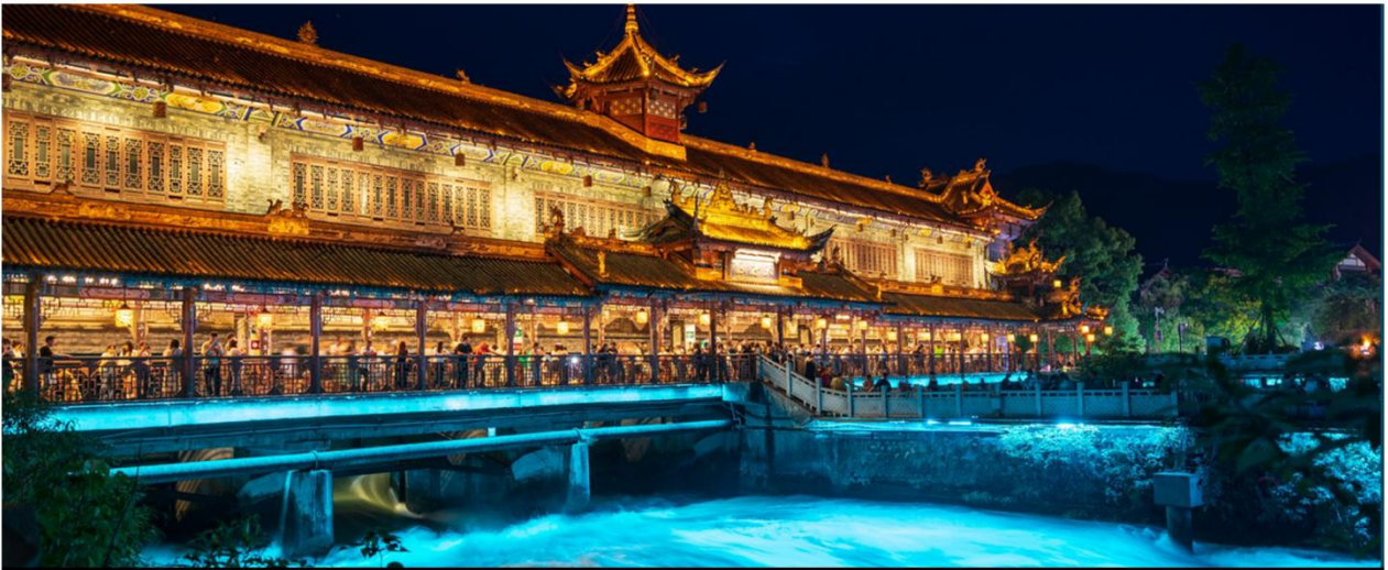
น้ำตาไฟฟ้าเขื่อนตูเจียงเยียน
