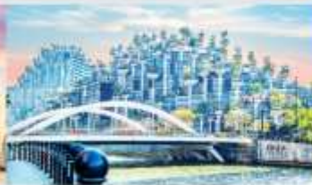
อาคารฟันทันไม้
