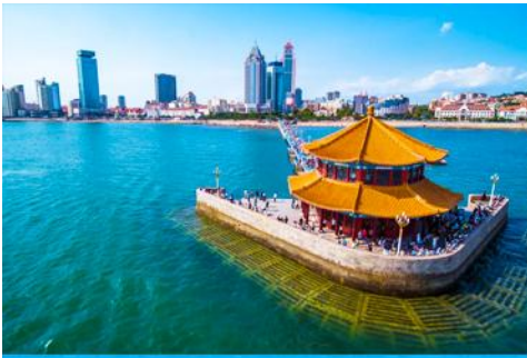
สะพานห้าแฉก
