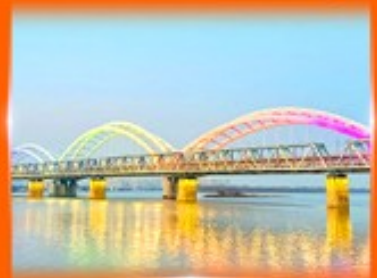
สะพานรถไฟอินโจว
