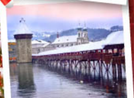
สะพานไม้ชาเปล
