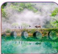
สะพานสิ่วซัง
