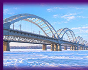
สะพานรถไฟป๋นโจว
