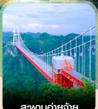
สะพานอ้ายจ้าย
