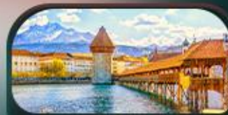
สะพานไม้ม้าเปอ
