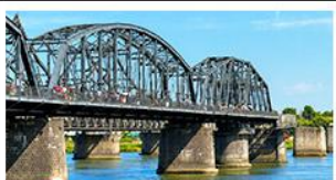
สะพานหวาดถานตง
