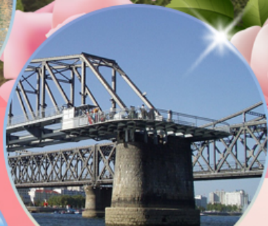
สะพานขาดตานตง
