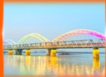
สะพานรุทโพนินโจว
