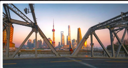
สะพานไวปู้
