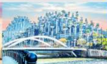
อาคารฟันทันไม้
