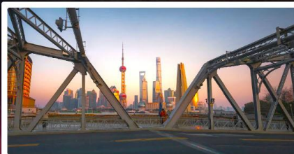
สะพานไวไปตู้
