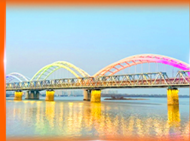
สะพานรถไฟปินโจว
