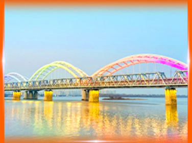
สะพานรถไฟปินโจว
