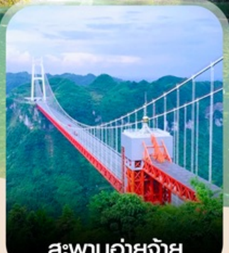
สะพานอ้ายจ้าย
