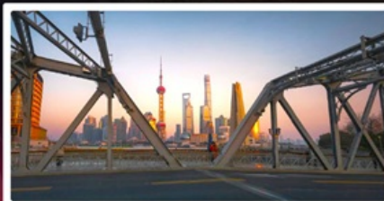
สะพานไวปี้ตู่
