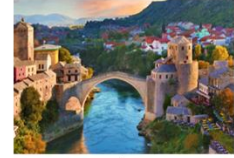
สะพานเก่า Mostar
