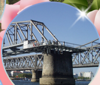
สะพานขาดตานตง
