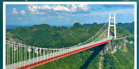
สะพานอ้ายจ้าย
