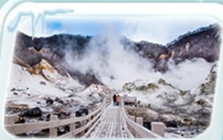
สะพานหอคจิกิดุทานิ
