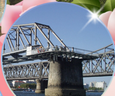
สะพานขาดตานตง
