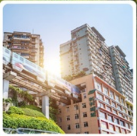
รถไฟฟ้าฉุดี้ก
