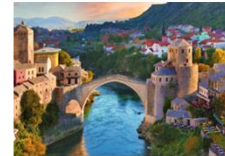
สะพานเก่า Mostar
