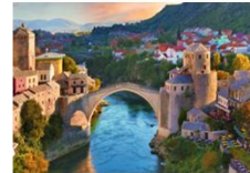
สะพานเก่า Mostar
