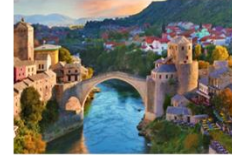
สะพานเก่า Mostar
