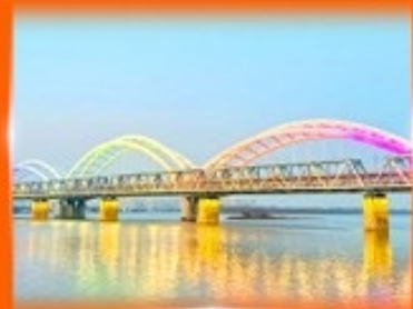
สะพานรถไฟผืนโจว
