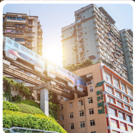
รตไฟทะลุตึก
