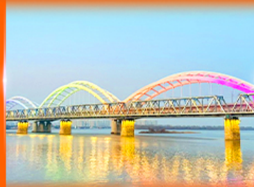
สะพานรถไฟปินโจว
