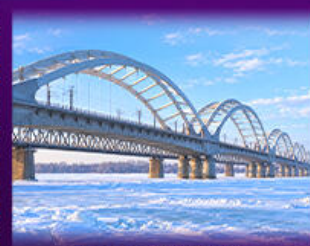
สะพานรถไฟโปนิว
