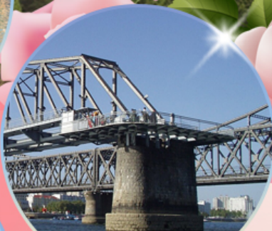
สะพานขาดตานตง
