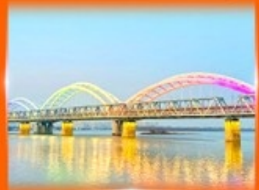
สะพานรถไฟผืนโจว
