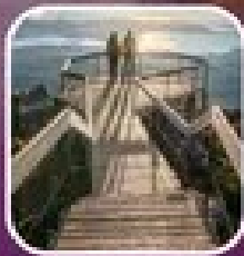
ชมสะพานไม้
