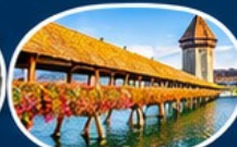
สะพานไม้อาเป
