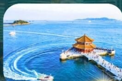
สะพานฉางเฉียว
