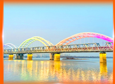
สะพานรถไฟปินโจว
