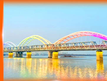
สะพานรถไฟปินโจว
