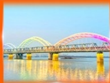
สะพานรถไฟผืนโจว
