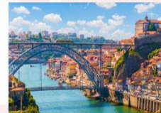
สะพาน Luis I Bridge
