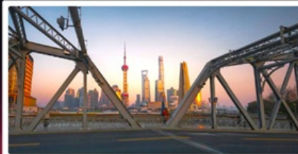
สะพานไวปี้ดู่
