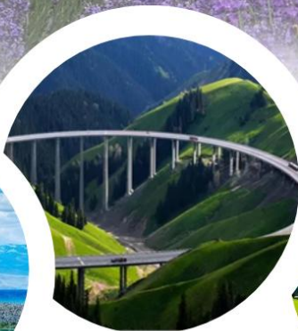
สะพานกัวจื่อโก
