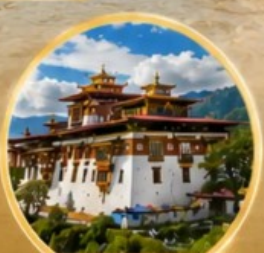
พูนาคาซอง
