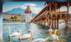
สะพานไม้ซาเปล
